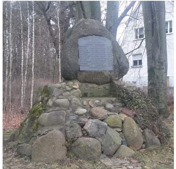
Zustand vor der Sanierung
