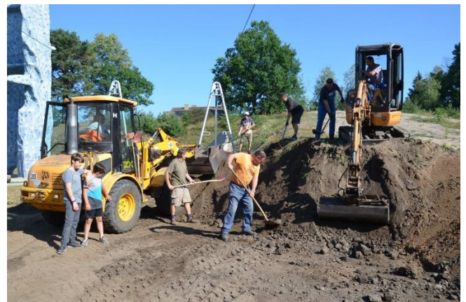
Erdarbeiten zur Errichtung der Seilbahn
