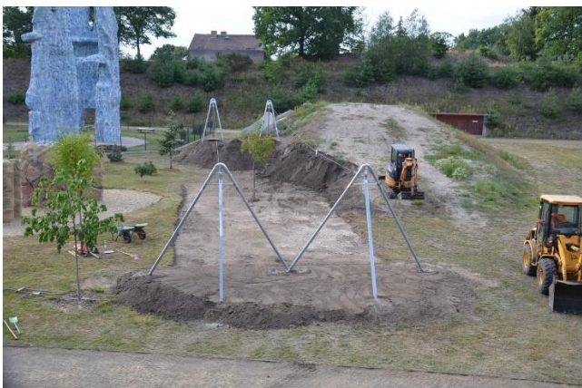
Seilbahnanlage im Bau
