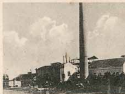
Kesselhaus u. Centrale
